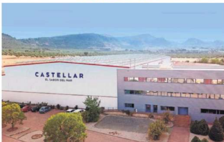
Trabajadoras de Castellar en la planta que la compañía tiene en Jaén.
